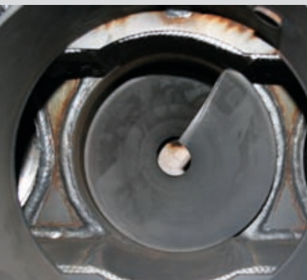
Savukanavissa on automaattinuo- hous mekaanisesti ruuveilla
