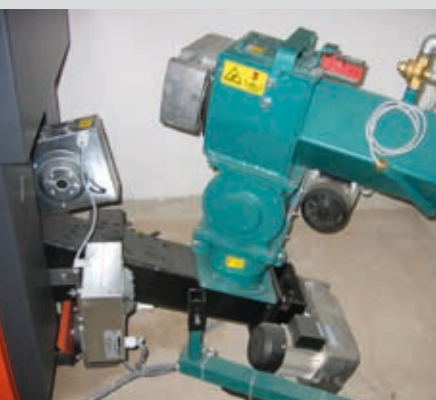
4-kammioinen lokerosyöttin vastaterällä
